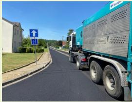
Les travaux de réfection de voirie touchent à leur fin dans les rues du Picon et du Val Fleuri. Après avoir réalisé les reprises d'eaux pluviales, la pose des bordures et les trottoirs, les enrobés ont été réalisés cette semaine par
